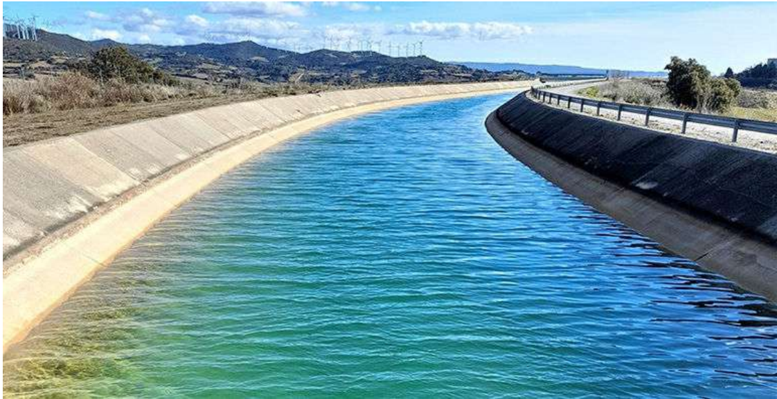
EL MITECO aprueba el proyecto de construcción de la segunda fase del Canal de Navarra
