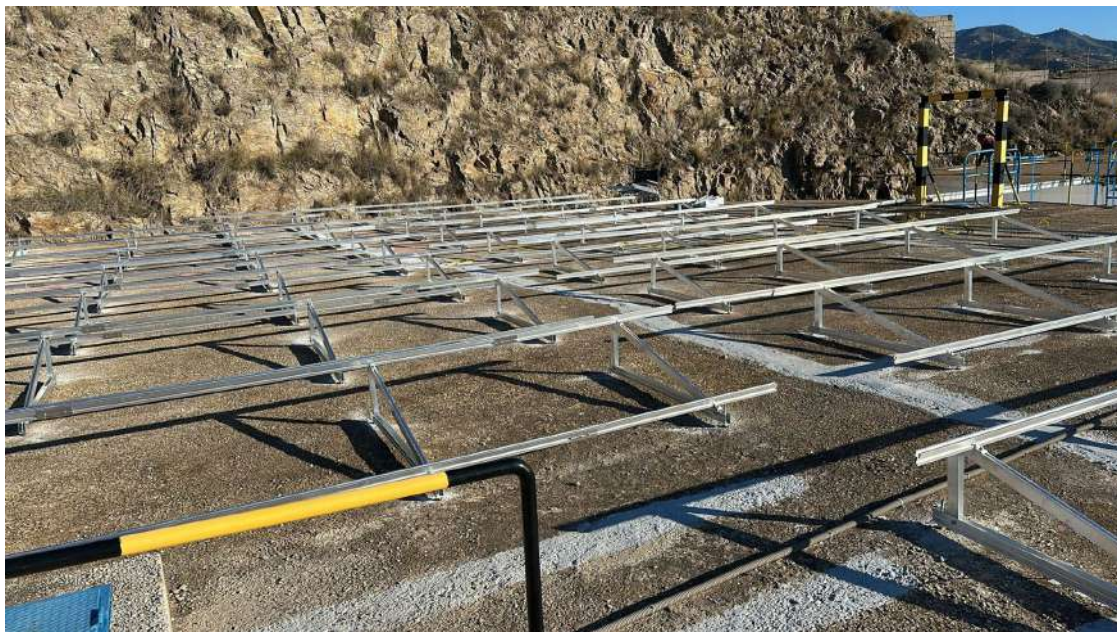
Preparación de estructuras para placas fotovoltaicas en el Depósito de Lo Colorao (EL FARO)
